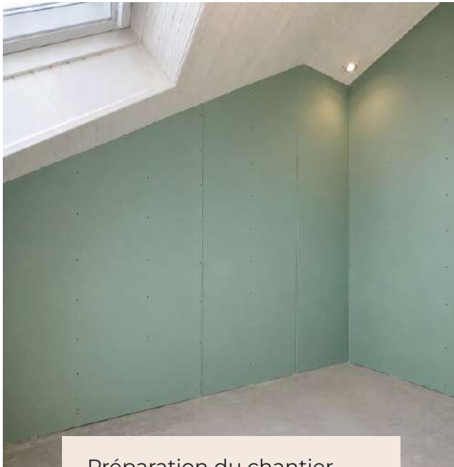
Préparation du chantier Habillage des murs
